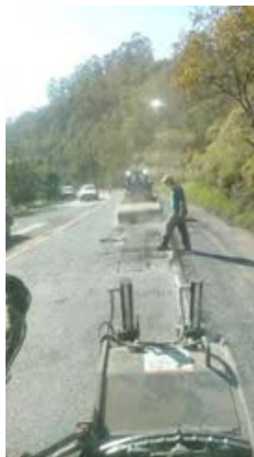
Tapa Buracos SC-350 Rio do Sul/Itaporanga - Projeto Recuperar
