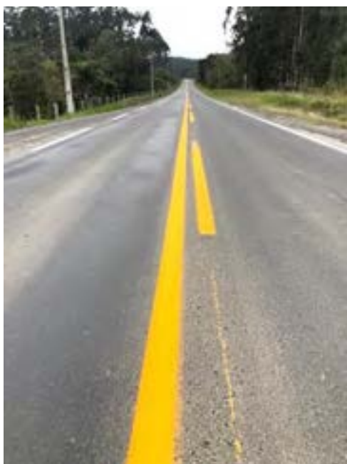
Sinalização Viária executada na SC-110 Itaporanga/Petrolândia - Projeto Recuperar
