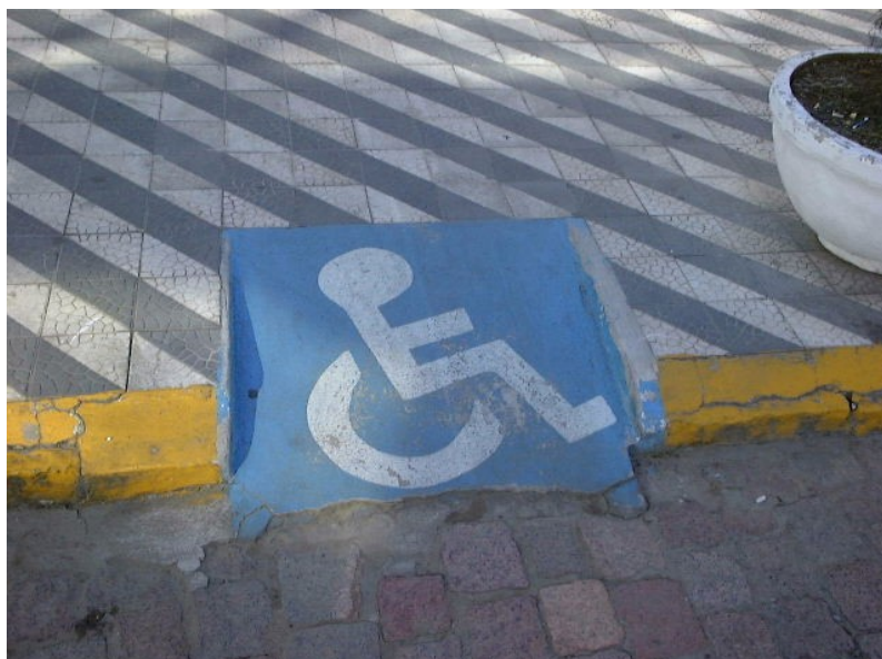
Sinalização e rebaixo de meio fio
