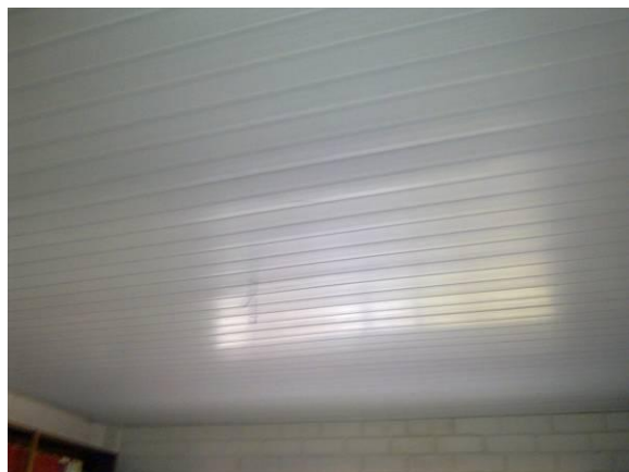
Reforma dos forros
